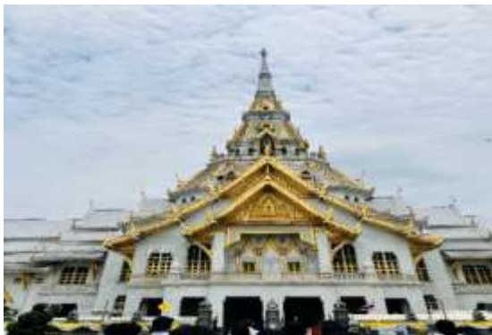
ワットソートーン外観
