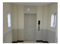
(校内エレベーター)
