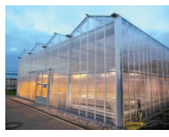
(スマート農業対応温室)
