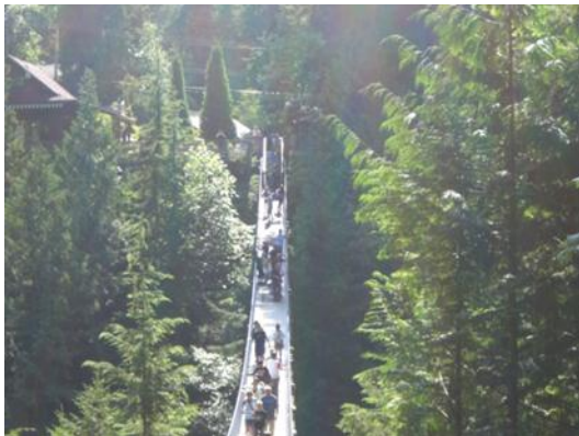
キャピラノ吊り橋
