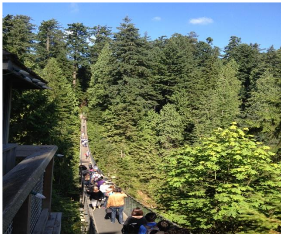
キャピラノ吊り橋
